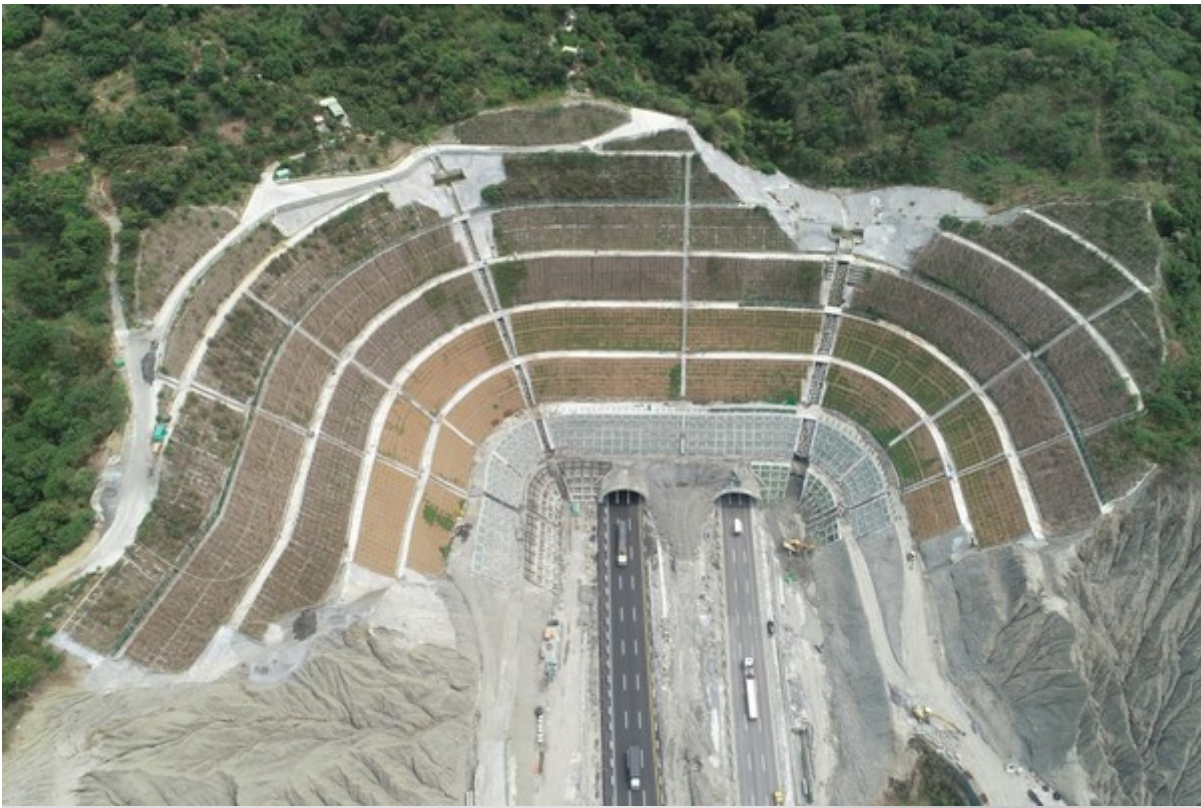
▲高工局表示，中寮隧道的結構不會受到影響。（圖／高公局提供）
